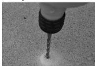
Просверлите отверстие, сверло 8 мм / 5/16 дюйма
